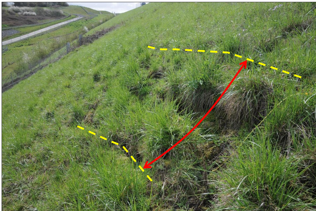
Figure 39. Décrochement observé au Nord de l'OH 103 sur le talus du sens 1
