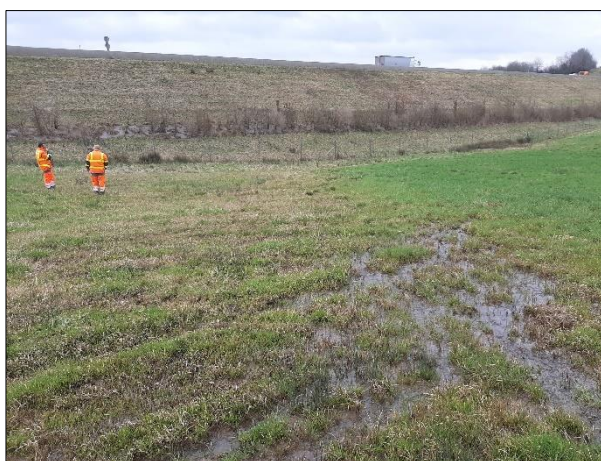
Figure 46. Venues d'eau en provenance du versant et s'écoulant vers le pied du talus amont de l'OT R9-B
