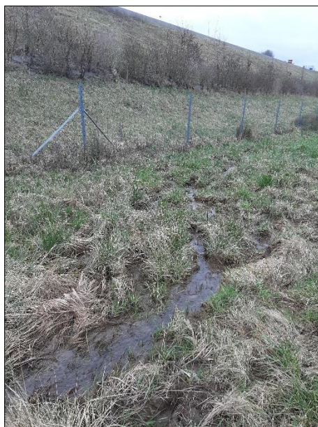
Figure 47. Ecoulement d'eau le long du pied du talus amont du R9-B
