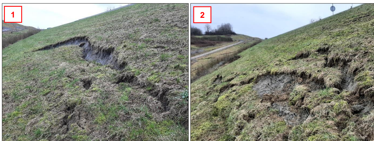
Figure 43. Aperçu des deux décrochements affectant le talus aval du R9-B – A gauche : glissement localisé au Sud de l'OH 103 – A droite : glissement localisé au Nord de l'OH 103
